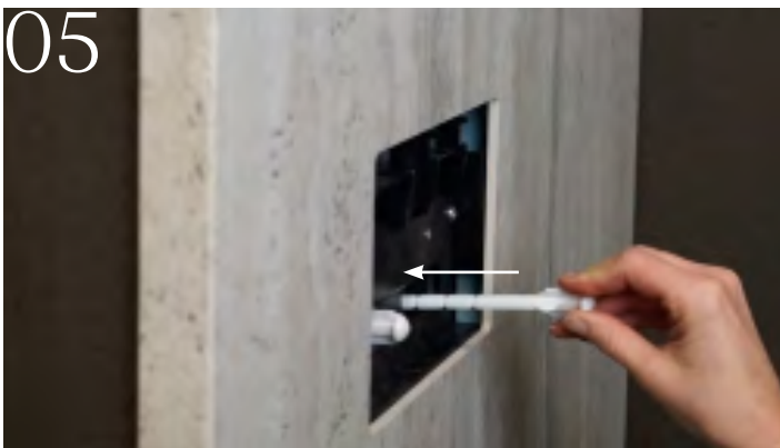
Drückerstäbe einsetzen
