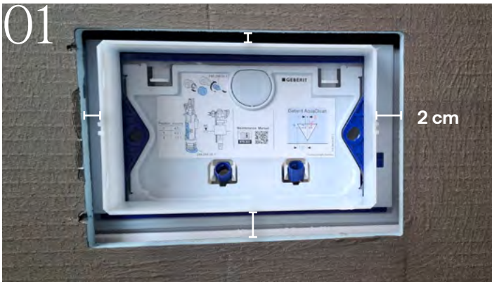
Umlaufend 2 cm Einbauluft einplanen.
