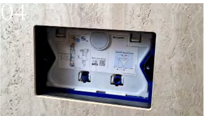
Tasten mit mitgeliefertem Plättchen leicht anheben und nach innen drücken.
