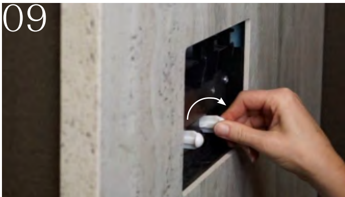
Drückerstäbe einsetzen, fixieren und Funktion prüfen
