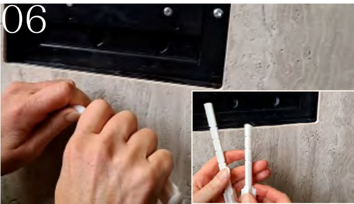
Bei Bedarf Länge der Drückerstäbe kürzen
